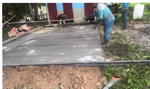
Foto 4: Reparación de losa de concreto para patio, considerando preparación de terreno, armado, nivelación y acabo rústico
