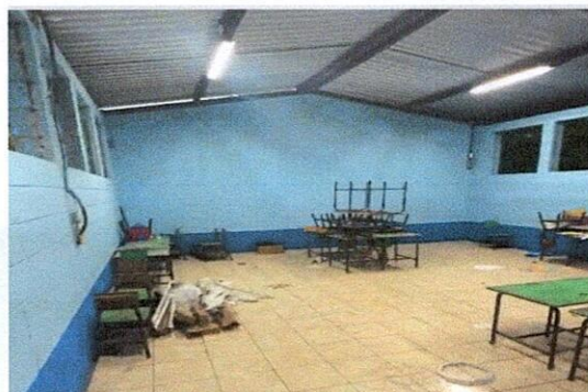
Foto 3: Sustitución de sistemas de iluminación: lámparas por lámparas tipo de Led.
