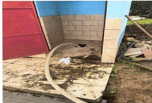
Foto 2: Sustitución de sanitarios, por sanitarios lavables, accesorios y conexiones.
